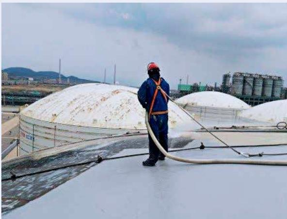
喷砂后使用加入缓蚀剂的淡水冲刷
