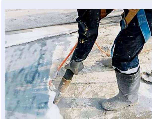
水喷砂过程 无灰尘污染、不会产生静电
