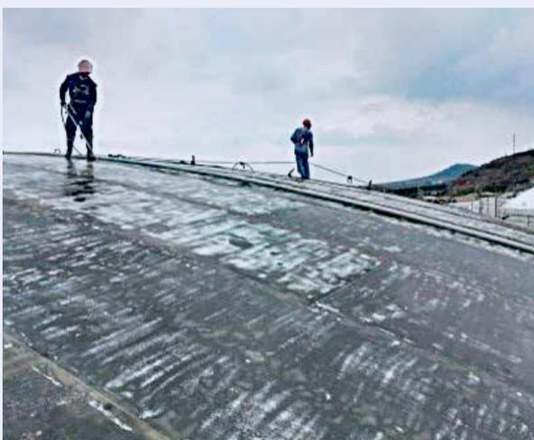
压缩空气吹干后的基材表面
