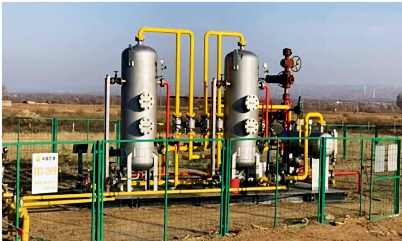
图3  $2 \times 10^4 \text{m}^3/\text{d}$ 井场液体脱硫一体化集成装置现场安装照片
