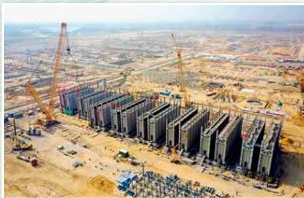
在广东石化项目建设中,中油工程充分发挥EPC一体化优势,成员企业工程建设公司、寰球工程公司、昆仑工程公司、项目管理公司联合参与项目建设,成功突破多个项目节点目标,奋力实现2021年的“开门红”。1月28日,广东石化项目120万吨/年乙烯装置裂解炉16台辐射室全部吊装完毕。
