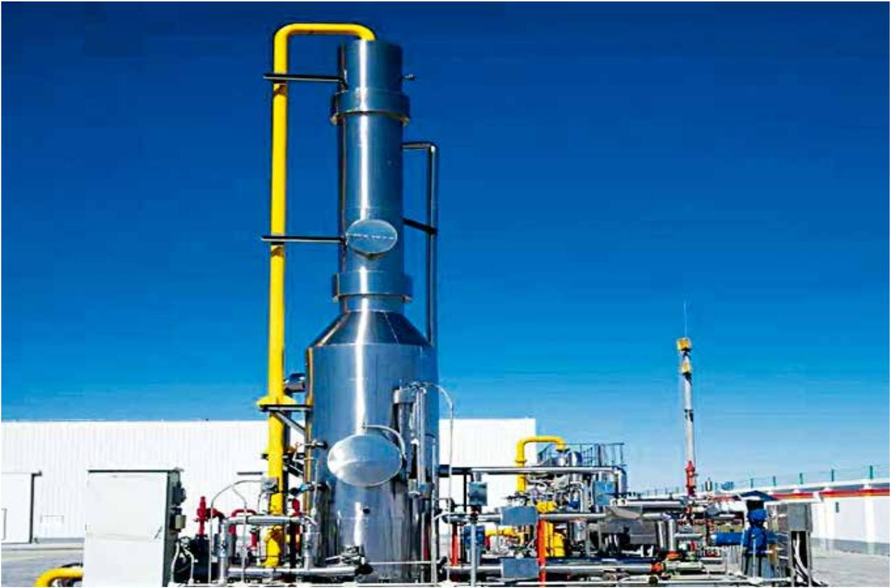
图4 30×10<sup>4</sup>m<sup>3</sup>/d液体脱硫一体化集成装置现场安装照片
