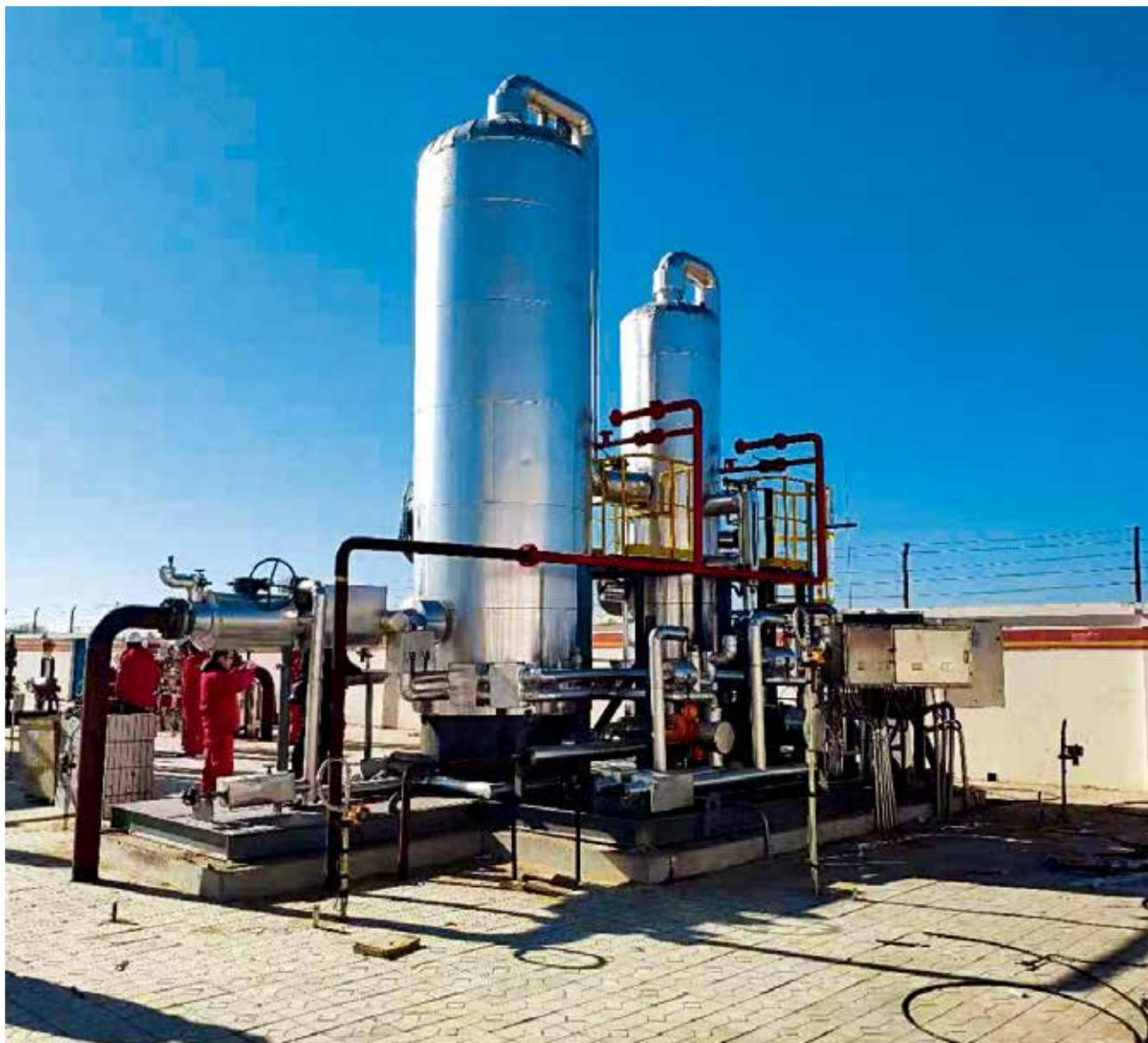
图5  $25 \times 10^4 \text{m}^3/\text{d}$ 联合研发液体脱硫一体化集成装置现场安装照片
