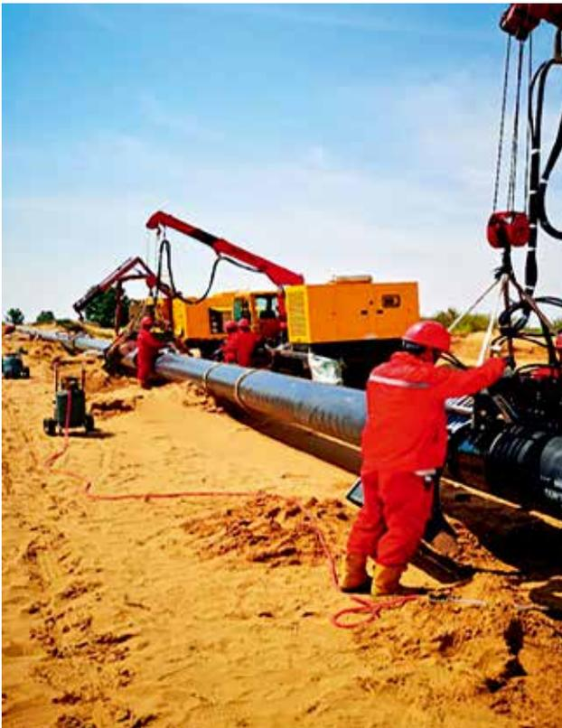
图2 调气管线机械化补口施工
