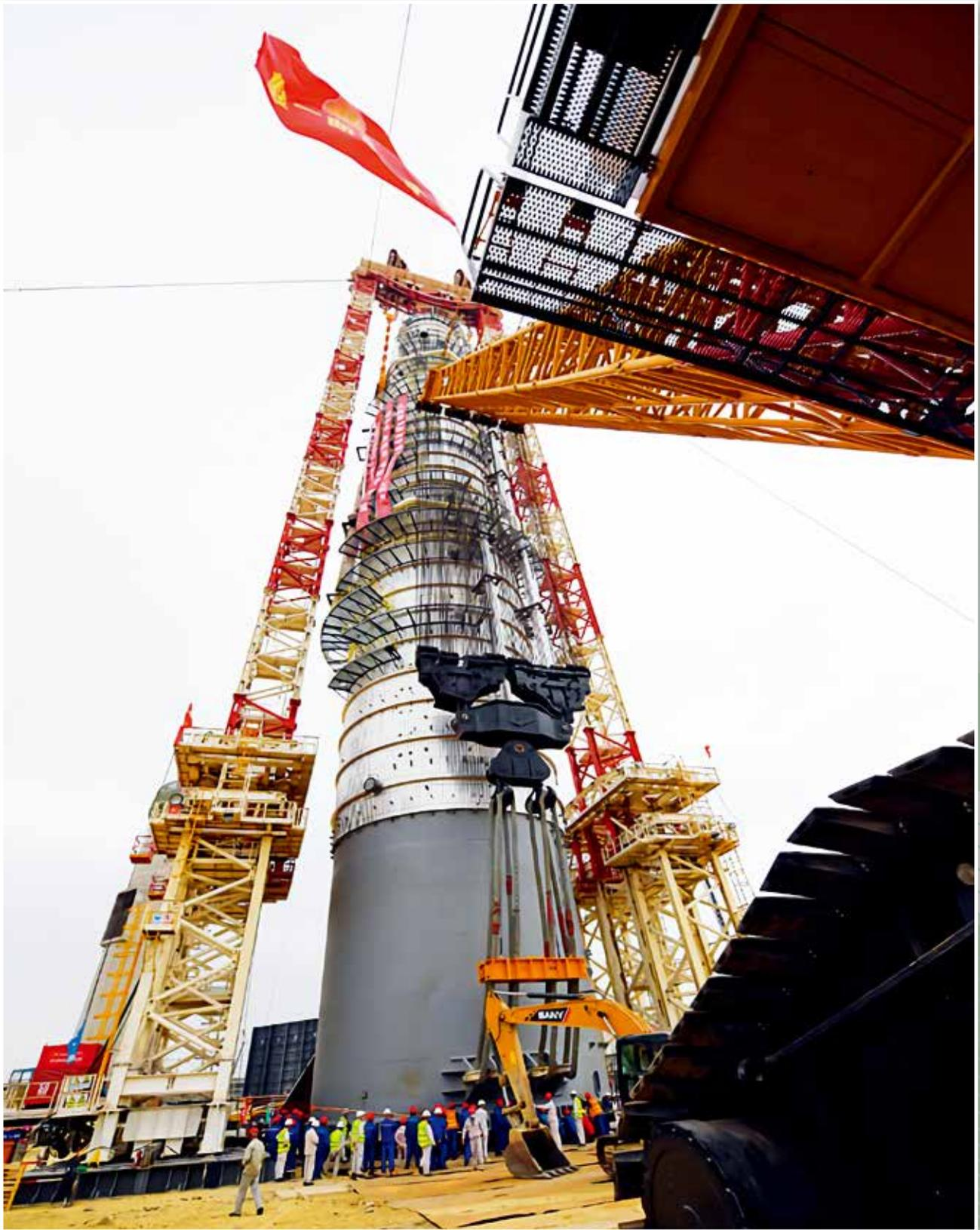
4月17日,在广东石化项目建设工地,由中国石油工程建设有限公司一建公司主导研发的世界最大MYQ 5000吨门式起重机,与“世界第一吊”徐工XGC88000 4000吨履带起重机首次“双剑合璧”,历时3小时30分钟,成功将4606吨抽余液塔吊装就位,一举刷新亚洲最重塔器吊装纪录,展现出中国装备制造、中国吊装的技术实力。
