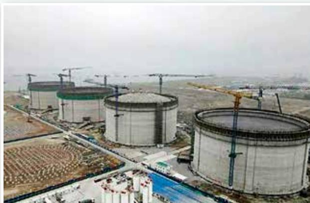
6月7日,寰球工程公司承建的北京燃气天津南港LNG应急储备项目首座22万立方米薄膜罐一次升顶成功,创造了我国单体罐容最大LNG薄膜罐记录,开创性地实现了薄膜罐建造技术在大型陆上LNG储罐的首次应用。
