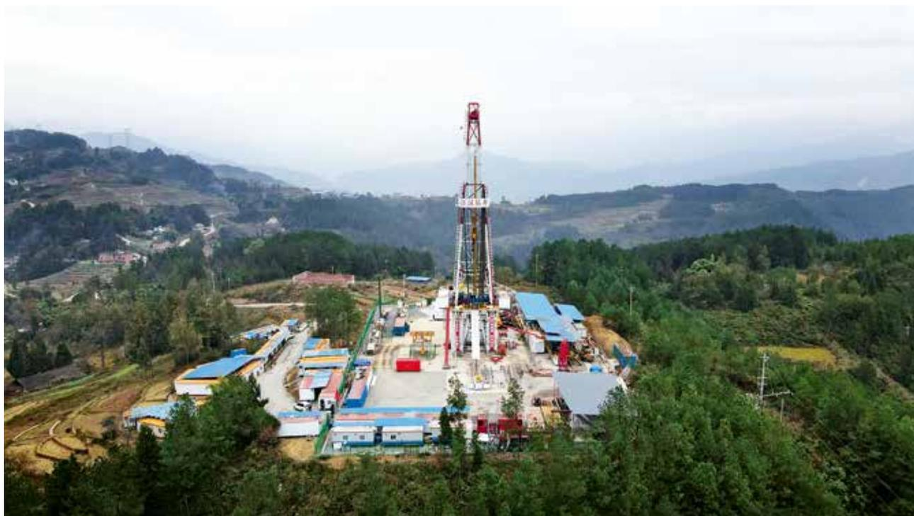
页岩气是一种以吸附、溶解、游离状态赋存于泥页岩中的清洁、低碳、非常规天然气资源。页岩气开发具有开采寿命长、产量高和生产周期长的优点,已成为全球油气资源勘探开发的新亮点。页岩气井多采用大规模水力压裂,其技术原理是利用储层的天然裂缝或人为诱导产生裂缝系统,将含有各种添加剂的压裂液在高压下注入地层,进一步扩大储层裂缝网络,再通过支撑剂支撑裂缝来改善储层裂缝网络系统,从而达到增产目的。
