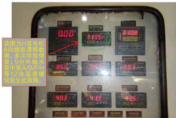
图2 H泵电机绕组数据漂移
