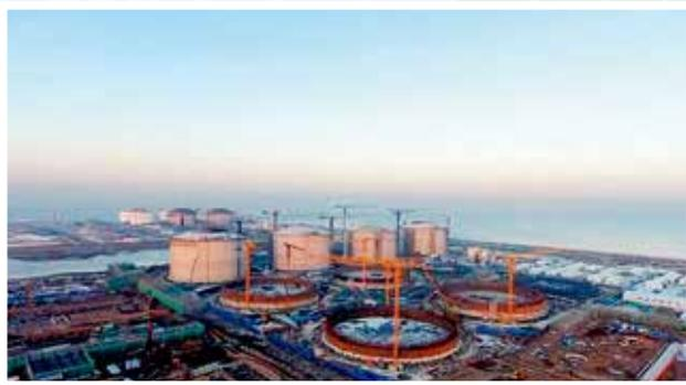
11月26日,从寰球工程公司获悉,天津南港LNG应急储备项目T-6201储罐穹顶第七段混凝土浇筑顺利结束,标志着储罐一阶段项目穹顶混凝土施工节点圆满完成,后续四台储罐主要施工内容将由外罐土建转入内罐安装施工。
