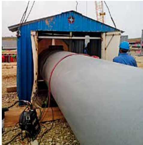
图6 大管道焊接防风、防雨篷
