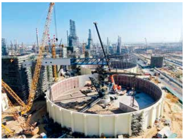
2021年12月14日，寰球公司广东石化石油焦制氢装置输煤系统中，单体最长、最重、最难安装的5#输煤栈桥钢结构桁架顺利吊装就位。
