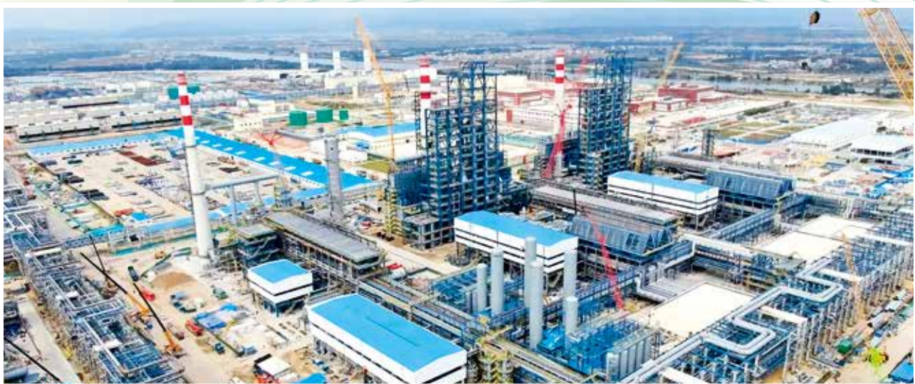
寰球公司五联合分项目部以石脑油加氢装置能达到机械完工条件为使命，抢抓关键线路。2022年1月，石脑油加氢装置陆续实现装置塔C-1001内件安装，压缩机二次灌浆，并顺利完成7个试压包的试压任务，以94%的施工进度，成为寰球项下主要装置施工进度第一名。
