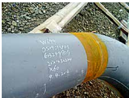
图3 焊口标识现场图
