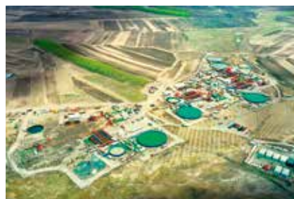
P11 智慧化安全管理平台助推项目管理技术升级
