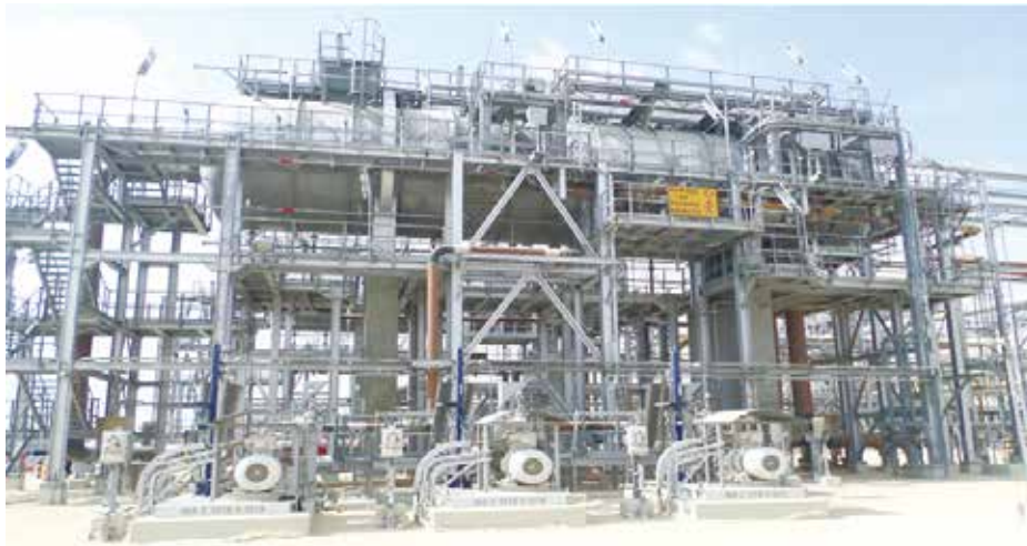
图1 射流气浮装置现场安装图
