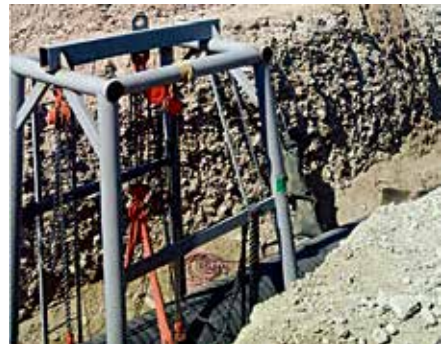
图2 组对吊具支撑架
