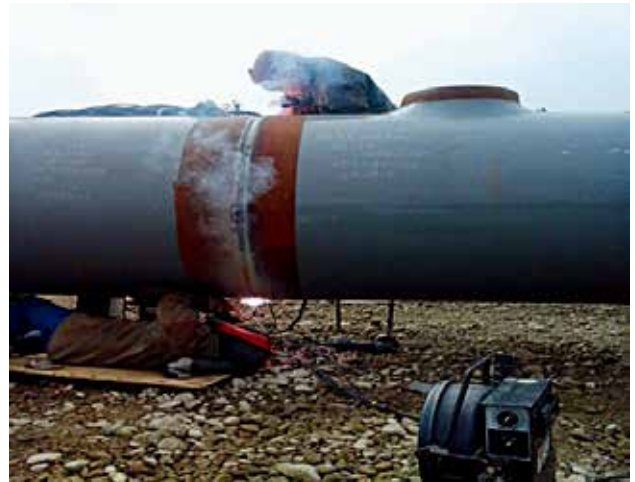
图7 进行中的向下焊
