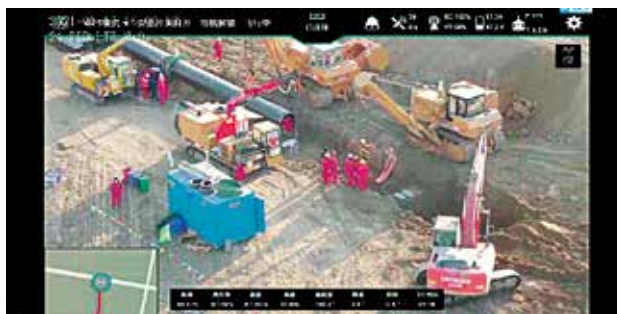
图3 无人机参与远程质量和安全检查
